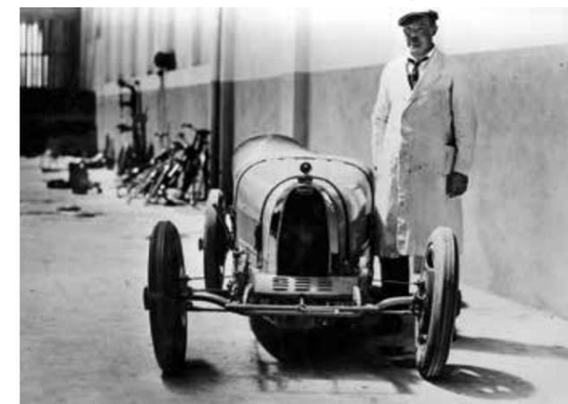
Photo d'usine du prototype du type 35 avec son radiateur étroit, ses pneus de faible section, sa carrosserie dépourvue pour plus d'efficacité
