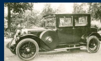
Coach Ballot bicolore avec malle arrière et coffre à outils dans le marchepied. La roue de secours reçoit une housse en simili pour plus d'élégance.
